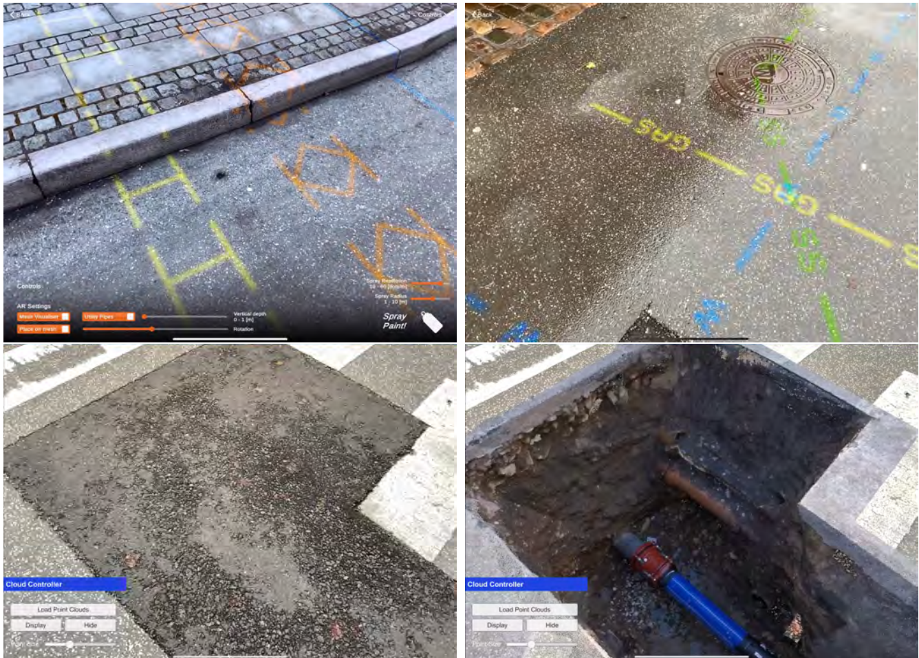
Abbildung 6. Außenanwendung von AR für Grabungsarbeiten. Die beiden oberen Bilder zeigen virtuelle Markierungen, welche direkt aus einer verfügbaren GIS Datenbank kommen und die eine sehr genaue Verortung von darunterliegender Infrastruktur ermöglichen. Die beiden unteren Bilder zeigt das 3D Modell von Untergrundinfrastruktur auf Basis einer zuvor stattgefundenen und dokumentierten Grabung (Bilder mit Setup aus Abb. 5 aufgenommen)
